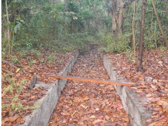
*Ilustración 83. Canales de mampostería para el control de inundaciones*
