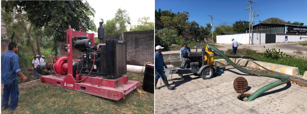
Ilustración 9. Bombeo de agua residual contenida en parcela agrícola y en la PTAR Norte I.
